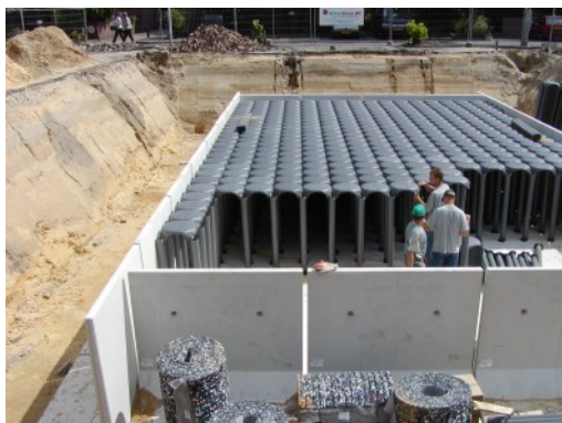
Figuur 4. Plaatsing van de Watershell Atlantis-cassettes.
