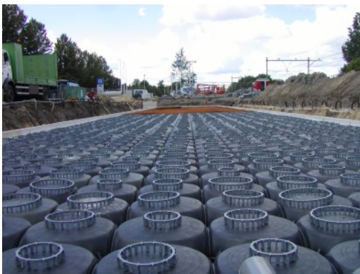
Figuur 5. Aanbrengen afstandshouders en wapeningsnetten.
