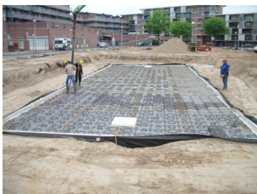
Figuur 6. Storten beton in kolommen en cassettes, rechts de stortrichting vanuit het midden.
