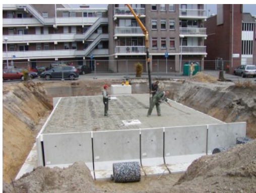
Figuur 7. Storten en verdichten van het kelderdek.
