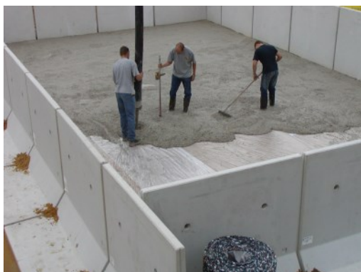
Figuur 3. Storten en verdichten van de keldervloer.
