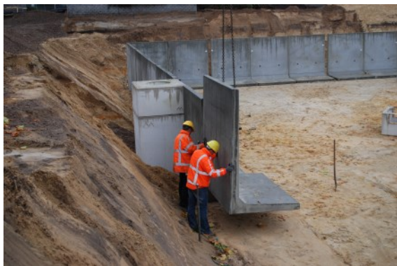
Figuur 2. Plaatsen van de keerwanden.
